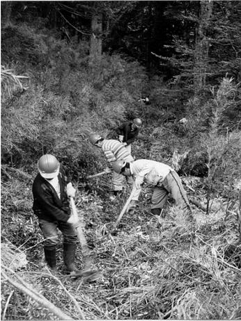
Una vez definido y recorrido el tramo entre cinta y cinta se procede a rozar, es decir, despejar el camino para que las cintas se puedan observar fácilmente. Se trata de un corte de vegetación preliminar, que prepara el terreno para una fase posterior de construcción en la cual vendrá una limpieza más amplia.
